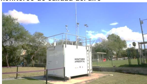
Imagen 3.- Estación de monitoreo de calidad del aire
