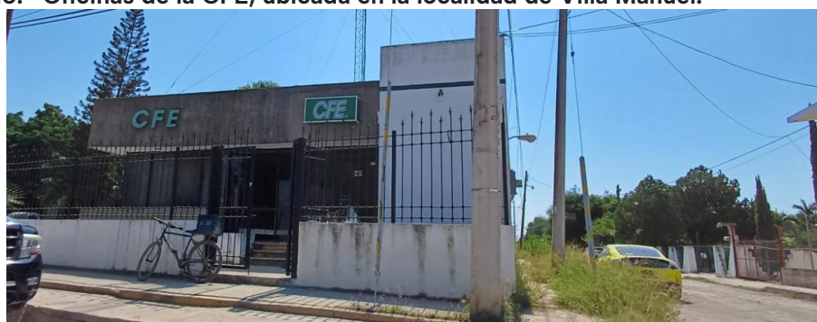
Imagen 16.- Oficinas de la CFE, ubicada en la localidad de Villa Manuel.
