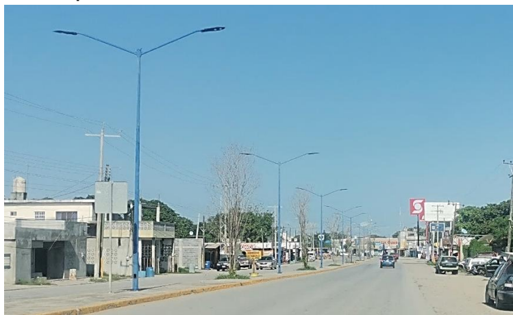
Imagen 31.- Alumbrado público en la localidad de Estación Manuel (Úrsulo Galván)
